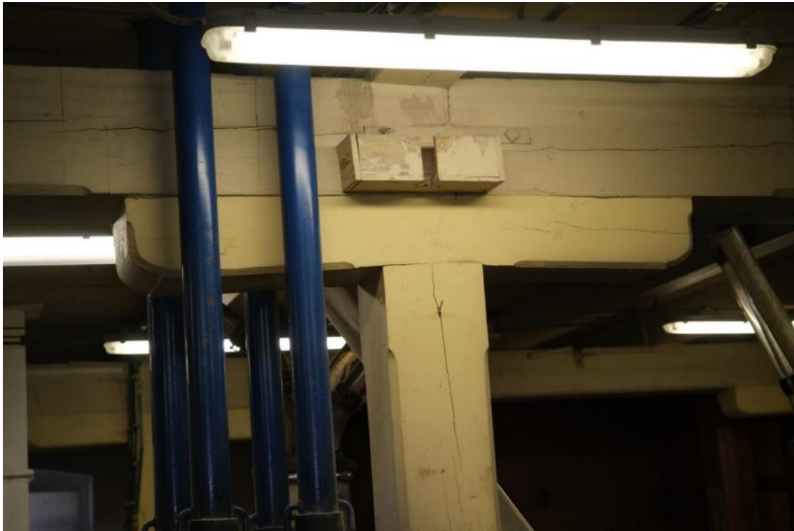
Obr. 35 Pohled na styk sloupu, průvlaku a stropnice
