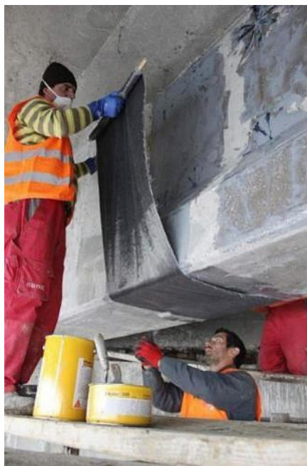
Obr. 2 Zesílení ve smyku
