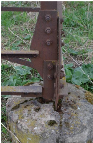
Obr. 3 Pohled na patku stožáru
