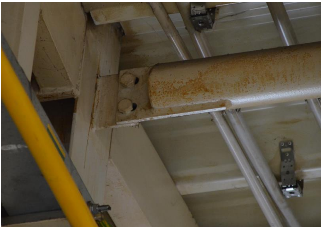
Obr. 12 Příklad nesprávných oválných otvorů
