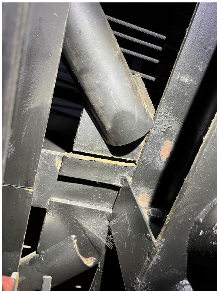
Obr. 26 Provedení styčnicku ztužení
