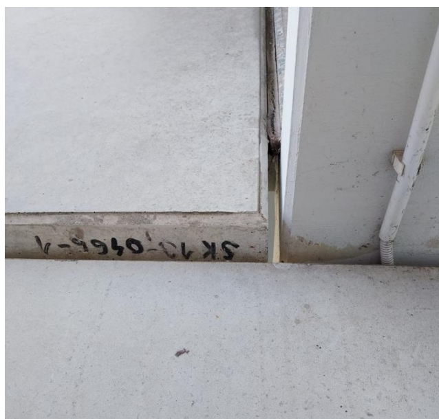
Obr. 30 Svislá deformace panelu na lávce oproti podestovému panelu u výstupu z výtahové šachty
