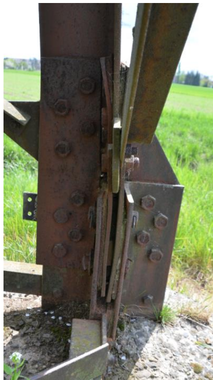
Obr. 5 Pohled na patku stožáru
