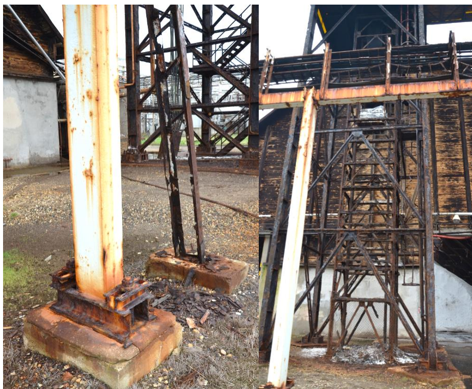
Obr. 23 a 24 Odstavené konstrukce
