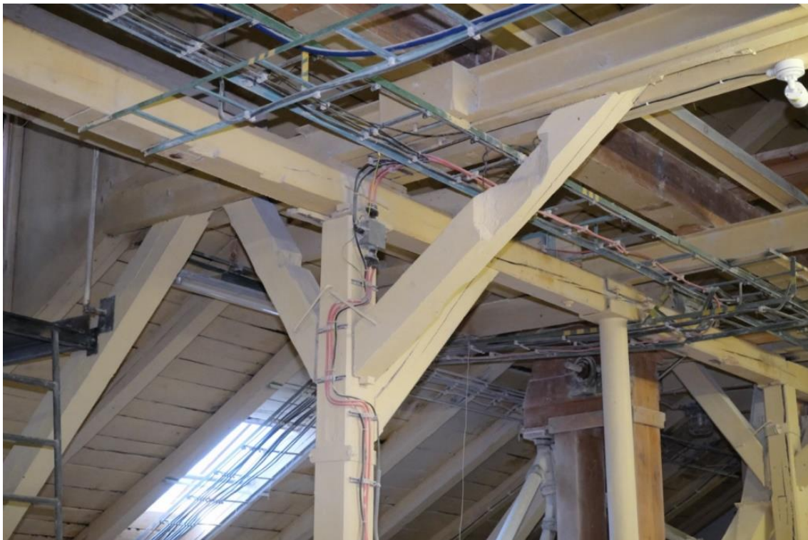
Obr. 38 Pohled na prvky krovu
