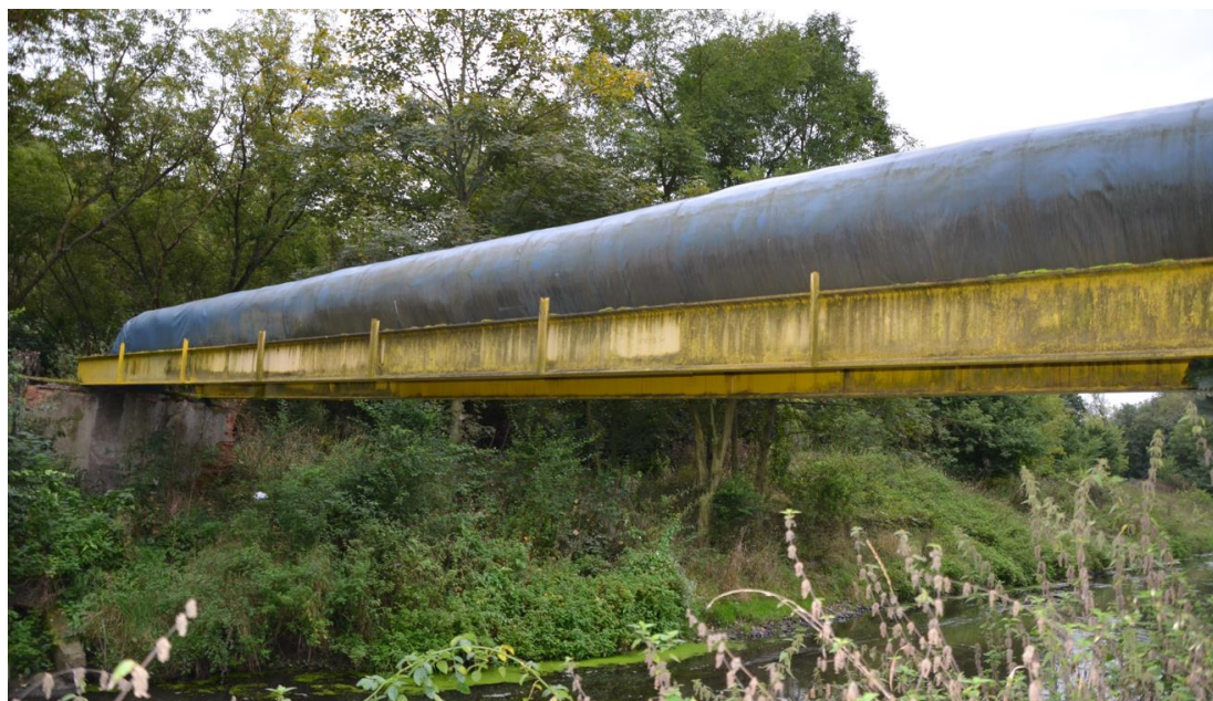
Obr. 15 Pohled na konstrukci
