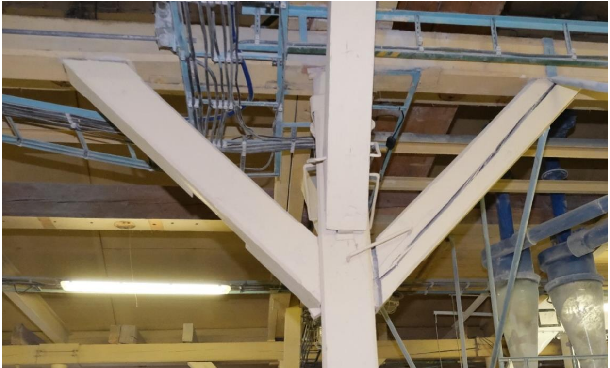
Obr. 37 Pohled na prvky krovu
