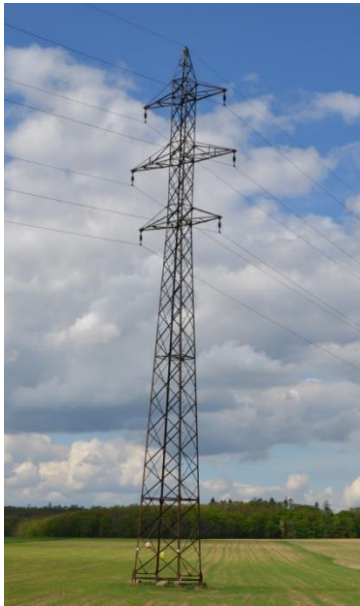
Obr. 1 Pohled na stožár
