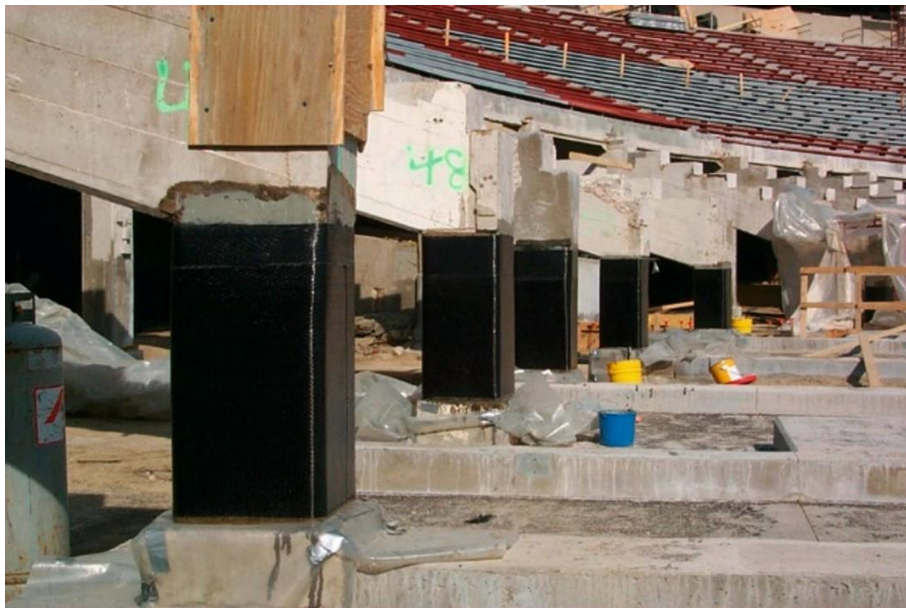
Obr. 3 Zesílení sloupu
