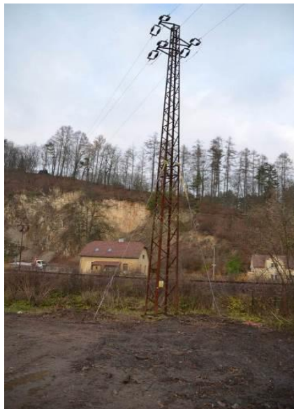
Obr. 6 Pohled na stožár
