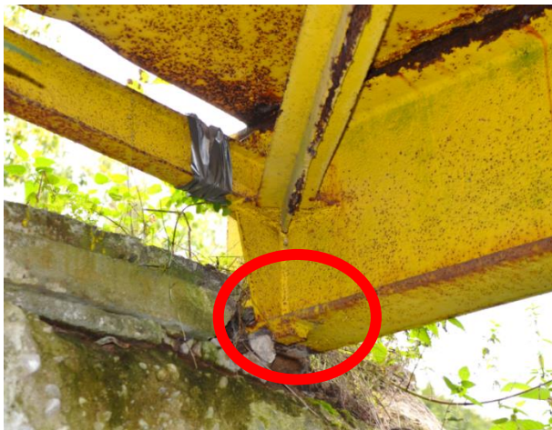
Obr. 17 Místo uložení do opěry se zarážkou
