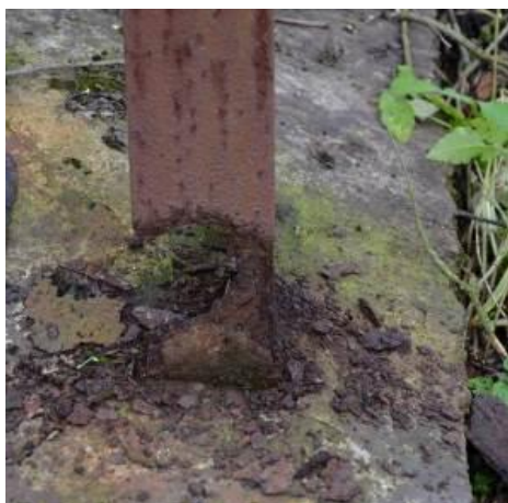
Obr. 7 Dřívky u přechodu do betonového základu po ručním očištění
