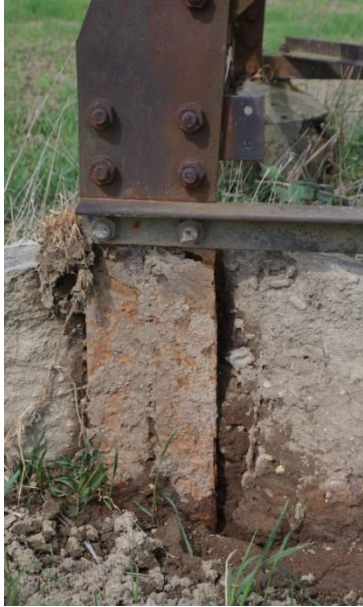
Obr. 4 Pohled na patku stožáru
