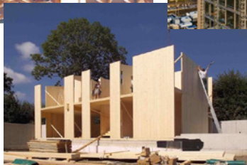
Masivní desková konstrukce
